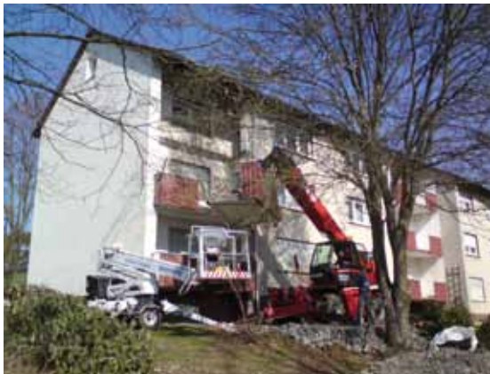
Alte Balkone werden abgeschnitten ...
